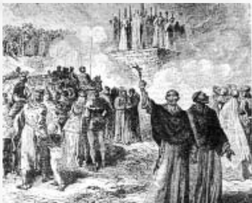
Massenverbrennung von Katharern
